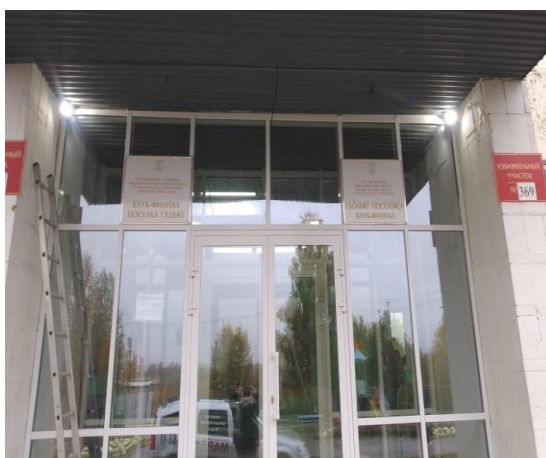
Ремонт входной группы в клубе-филиале пст. Седью
