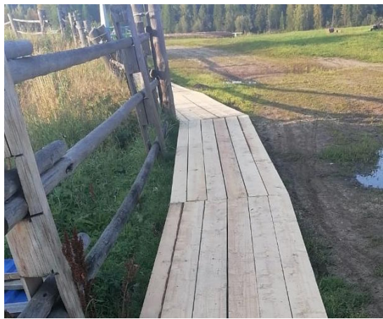
Ремонт тротуара в д. Поромес
