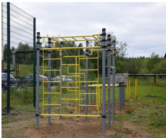
Ремонт и обустройство спортивно- игровой площадки по ул. Школьная
